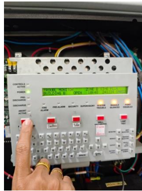
รูปที่ 2-63 ตรวจสอบระบบป้องกันและเตือนอัคคีภัย
